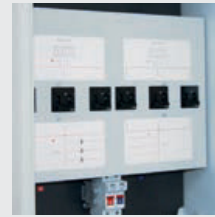
Batterieabsicherung SONY-Speicher für dreiphasige SMA Sunny Island Systeme
